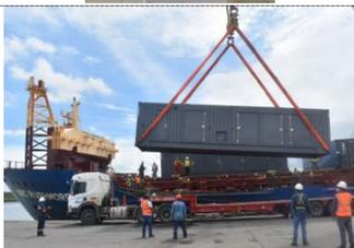
**El Universo. Desembarcan 16 nuevas unidades para la central térmica Esmeraldas III.** Estas unidades conformarán la tercera isla de generación, con una capacidad de 33,3 MW. Una vez culminado el proceso de desaduanización, los equipos —que ya cuentan con motor y generador acoplados— serán trasladados al sitio del proyecto para comenzar las pruebas de funcionamiento. [Ver más](#)
